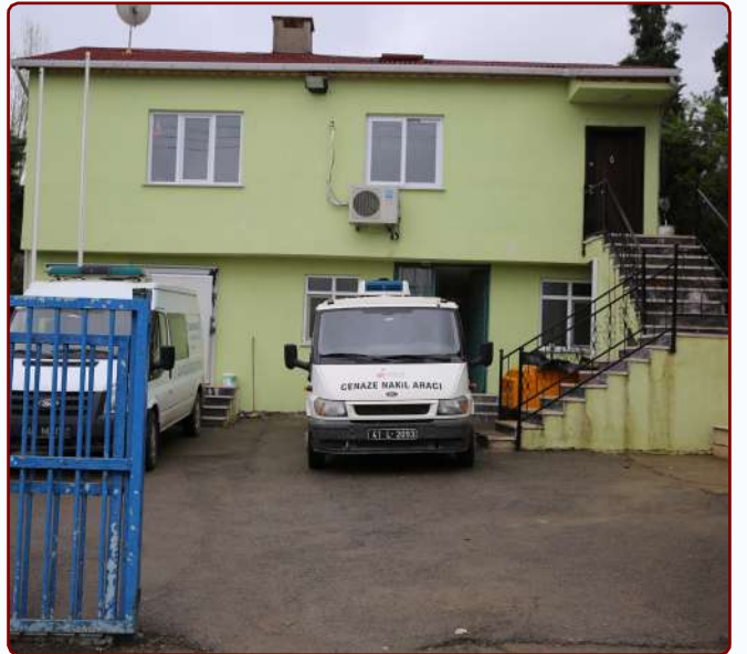
Mezarlık İşleri Hizmet Binası
